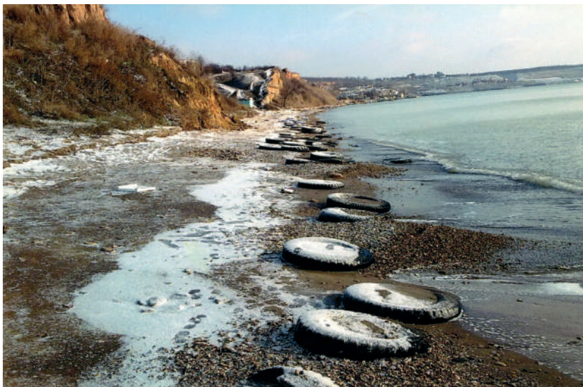
Рис. 4. Типовий приклад проектного рішення фахівців-екологів, які визначили «прогресивний метод» швидкого «ефективного» захисту абразійного берега Одеської затоки (Чорне море) без вживання гідротехнічних споруд.
