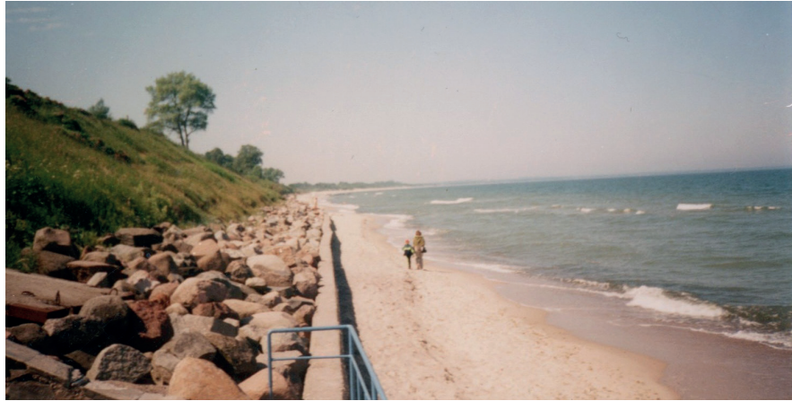
Рис. 3. Кам'яно-накидний банкет з вертикальною хвилевідбійною стінкою для захисту піщаного берега від хвильового руйнування. Балтійське узбережжя Латвії (фото Ю. Д. Шуйського, 2004 р.)
