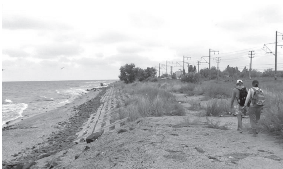
Рис. 1. Штучна берегова тераса («берма») для захисту залізниці від хвильового руйнування на піщаному пересипу Дністровського лиману (фото Ю.Д. Шуйського)
