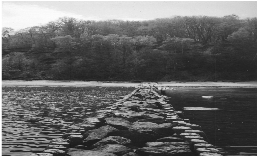
Рис. 1. Двухрядная свайная буна с каменным заполнением
