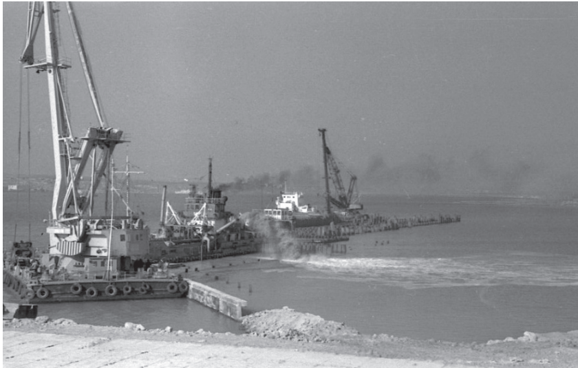
Рис. 5. Будівництво причалів (Найкрацій порт, 2021)
