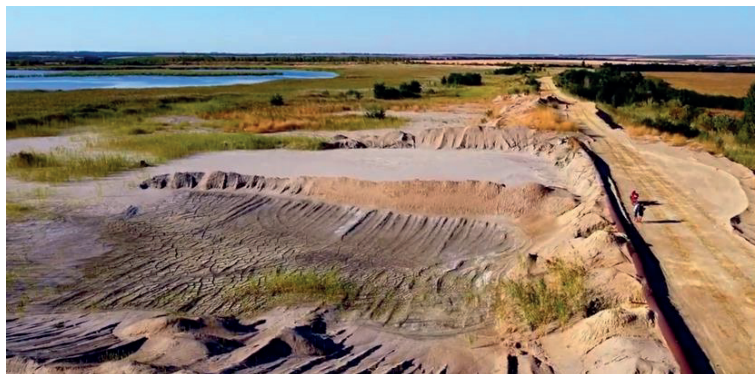
Рис. 14. Такири та еолові утворення, які нагадують аридну морфоскульптуру, виникають з висиханням твердої фази хвостів (фото О. Ситника)
