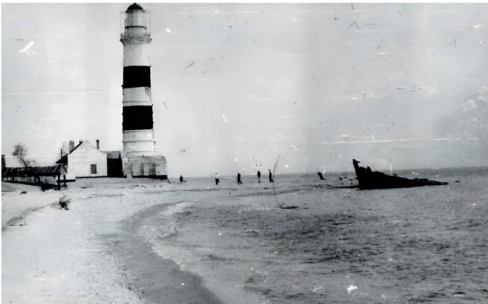
Рис. 3. Берег Тендрівської коси на ділянці розташування маяка, вигляд із заходу на схід. Результативний рух уздовжберегового хвильового потоку заповнює кут входження між береговою лінією та притопленим у вигляді буни судном «Дельта» вказує напрямок потоку із сходу на захід (фото Ю. Д. Шуйського, 1988 р.)
