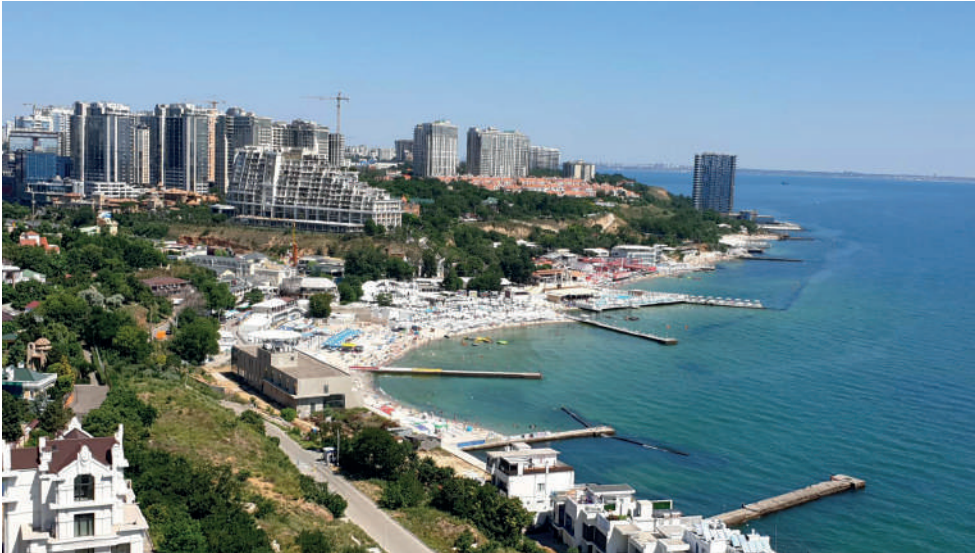
Рис. 5. Район Аркадійської бухти, південна межа 1-ї черги берегозахисту (рис. 2). Дизайн вдалого проекту забудови узбережжя Чорного моря в межах території Одеси. Показані провідні штучні споруди, в т.ч. видно темні лінії підводних хвилеламів (вид у північному напрямку).
