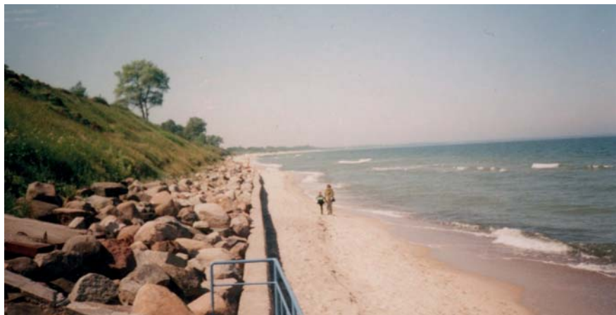
Рис. 3. Кам'яно-накидний банкет з вертикальною хвилевідбійною стінкою для захисту піщаного берега від хвильового руйнування. Балтійське узбережжя Латвії (фото Ю.Д. Шуйського, 2004 р.)
