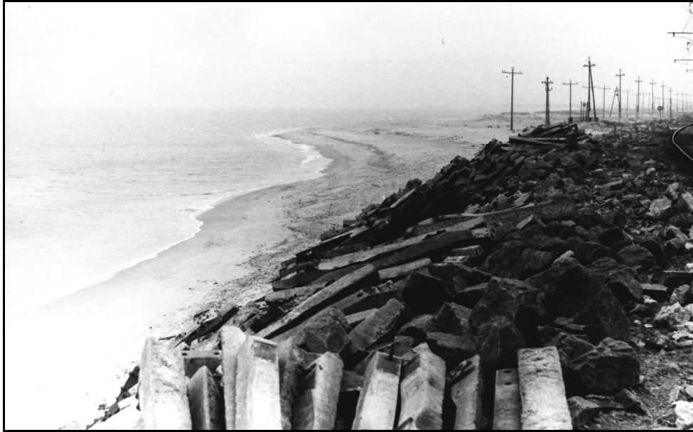
Рис. 2. Каменная наброска и шпалы не смогли защитить железнодорожное полотно от волнового размыва и штормового прибоа на Днестровской пересыпи, 1982 год (фото Ю. Д. Шуйского)
