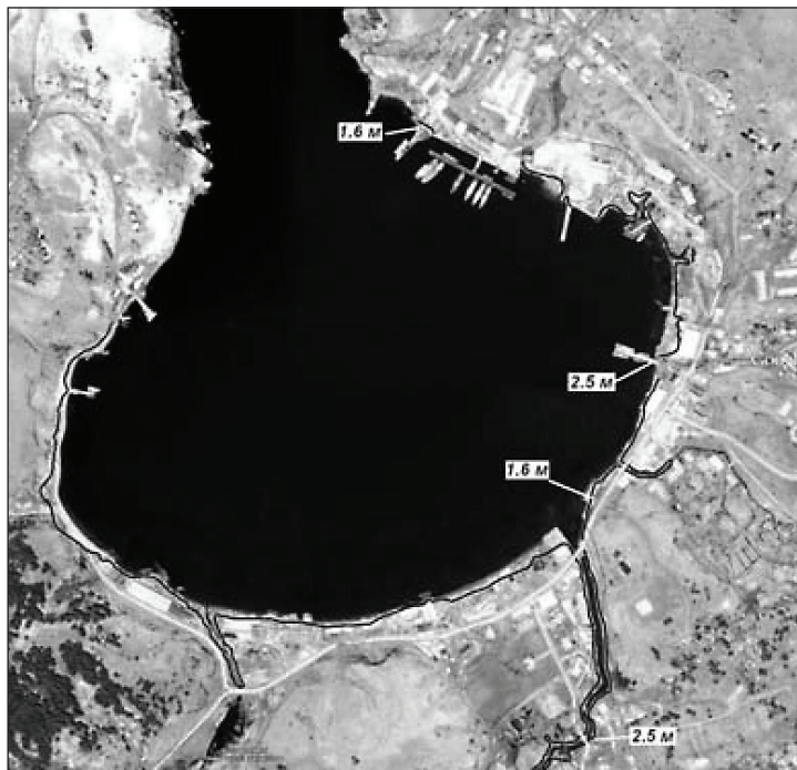
Рис. 5. Схема проявления цунами Тохоку в бухте Малокурильская. Граница зоны затопления берега показана темно-синей линией. Высоты заплесков соотнесены со средним уровнем в бухте.
